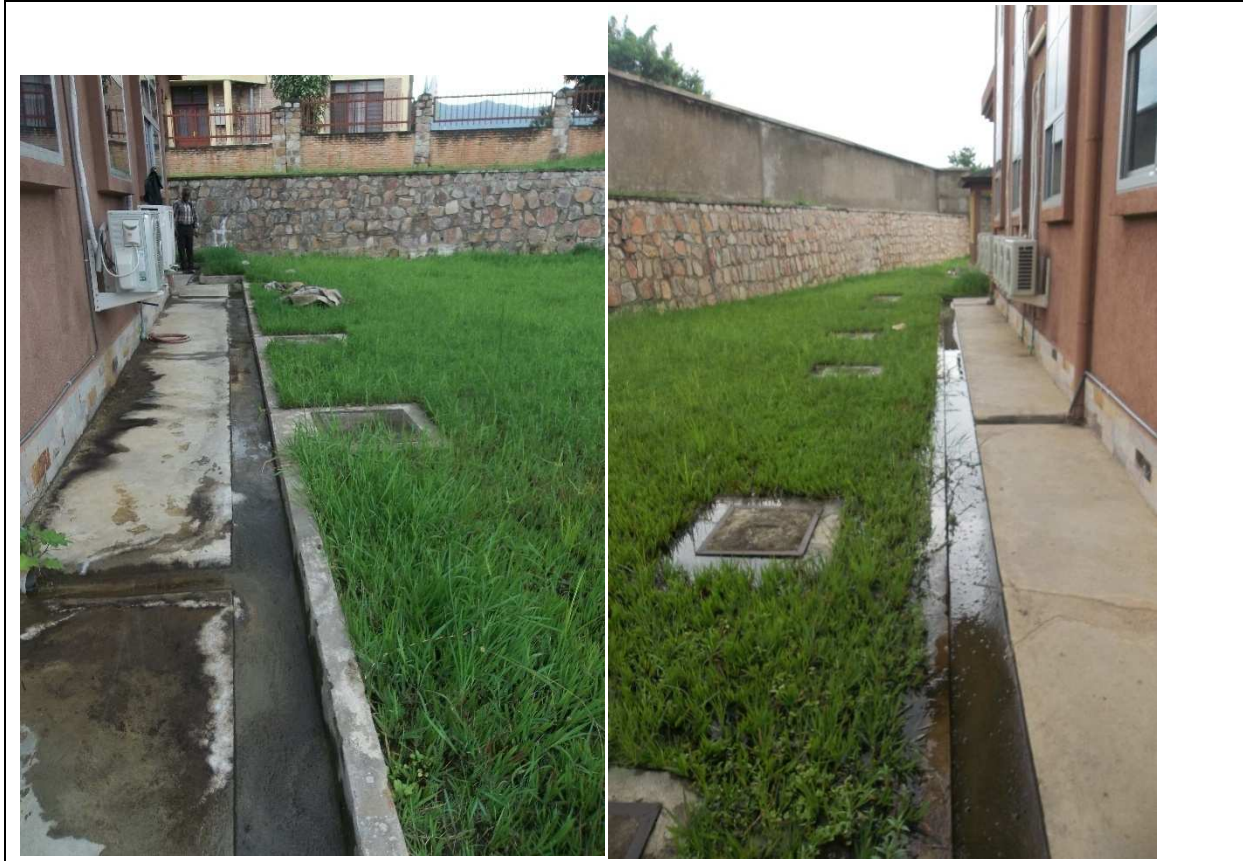
Figure2: Terrain imbibé du nouveau laboratoire du CHUK
