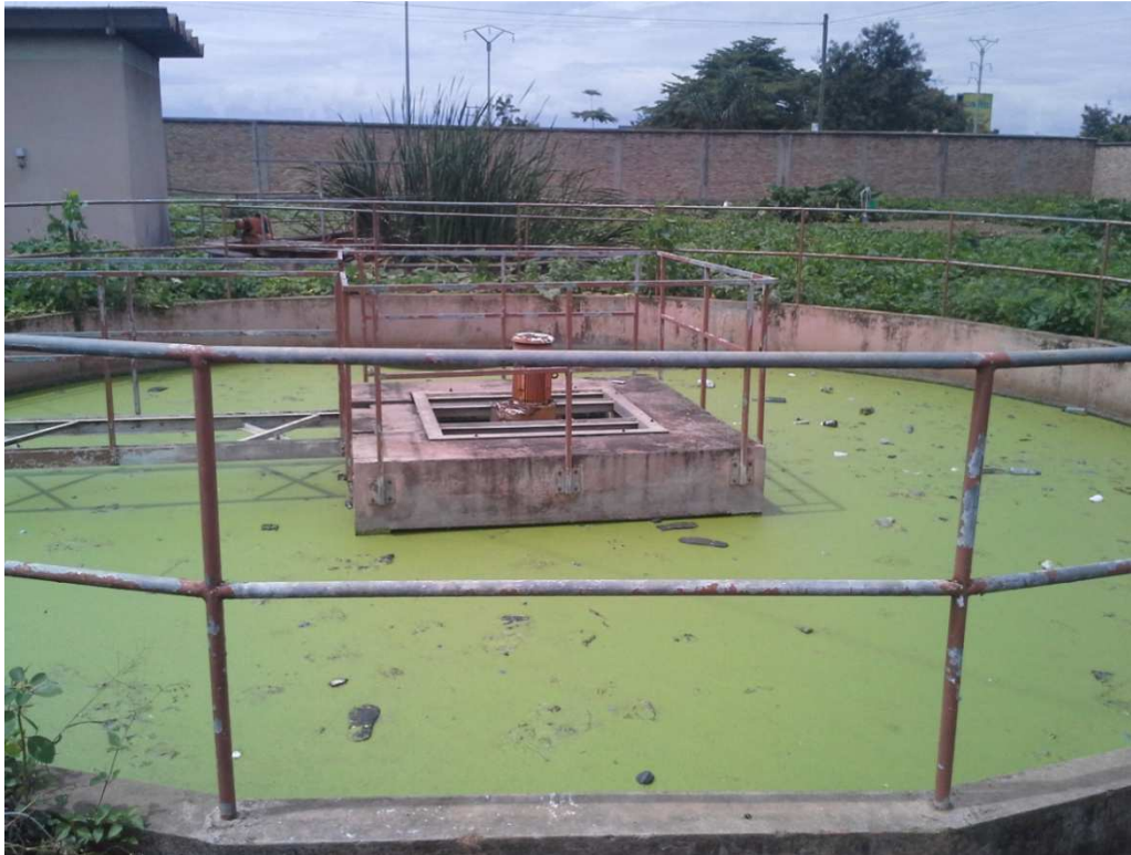
Figure 3: Station de traitement des eaux usées de CHUK de type boue activée malheureusement non fonctionnelle depuis environ 20 ans
